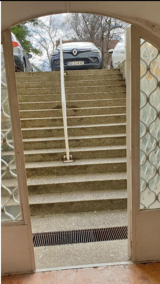
Pristup u zgradu s parkirališta sa stražnjeg dijela zgrade je nemoguć. Postoje dvije mogućnosti za realizaciju pristupa i to kroz podrumski prostor zgrade (streme stepenice u slici pokraj) koji vodi odmah do ulaza u lift no nažalost bez pristupne rampe i bez platforme za spuštanje.
